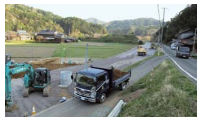
工事が始まった西方寺五明地区
